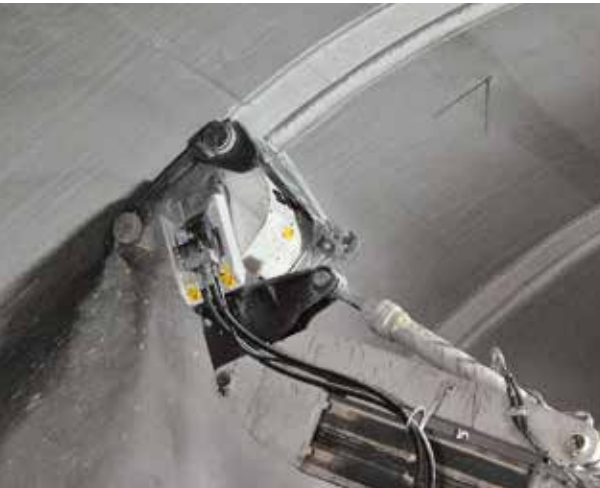
Fräsen von genau definierter Tiefe
